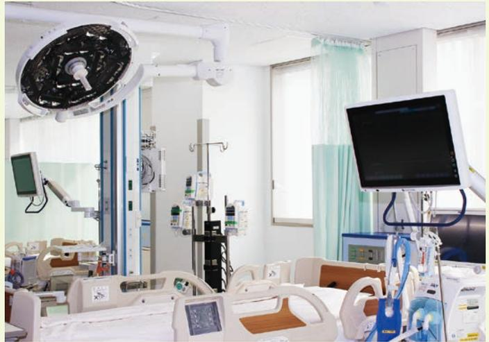
特徴的なのはコラムシステムと呼ばれる、各種モニターやエネルギー供給源を集約できる柱状の設備です。これ1本でモニター、人工呼吸器とその配管、吸引器、血液浄化装置やECMO
